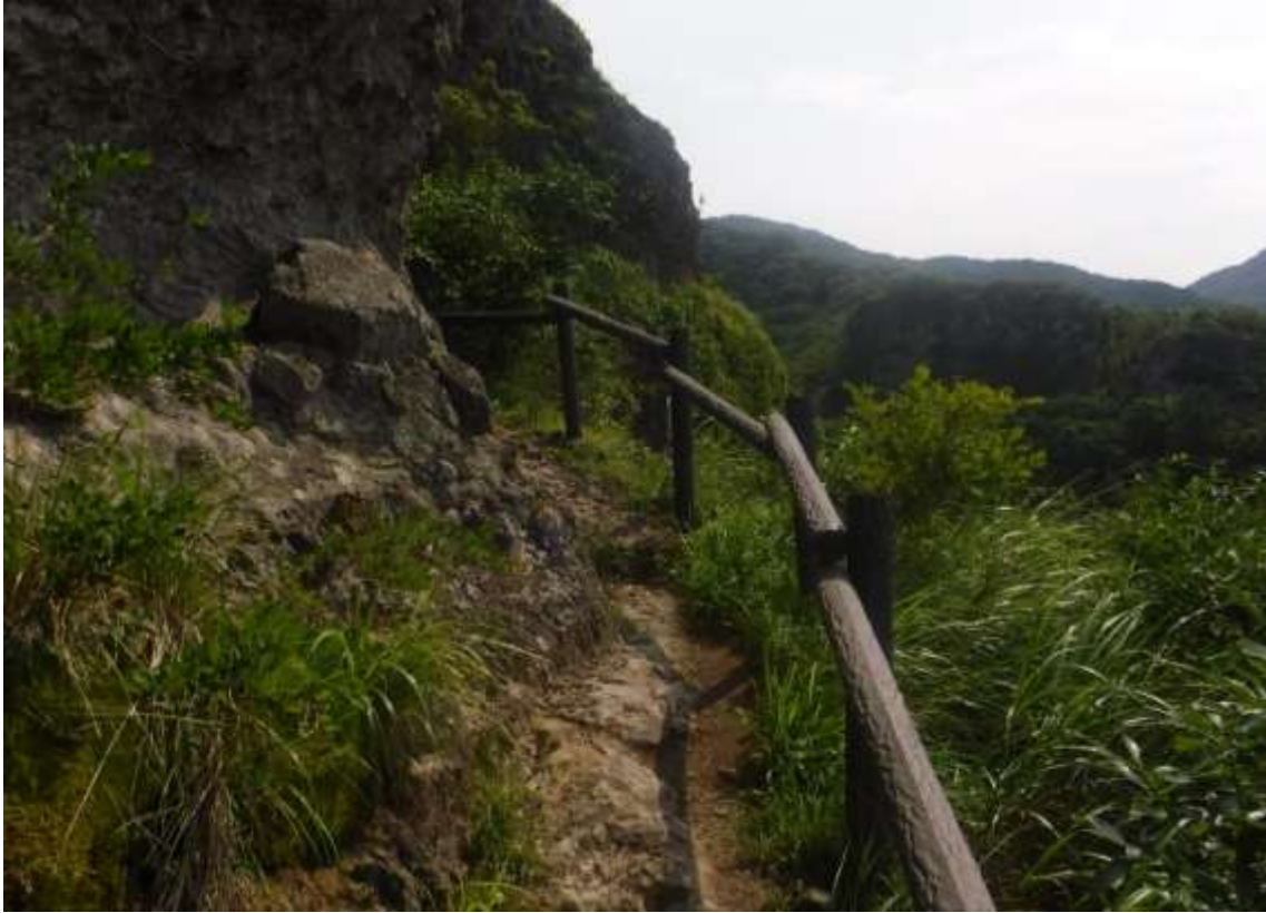
写真 10：峯道の手摺り設置状況
